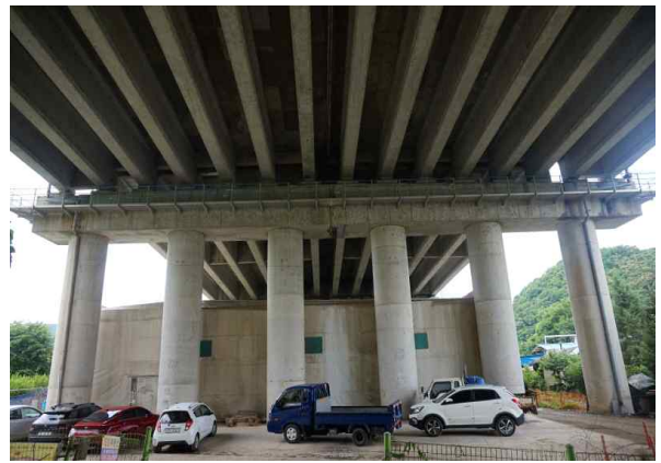
교각 P2 전경
