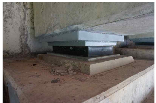
받침장치 보수 상태양호 A1 SH5
