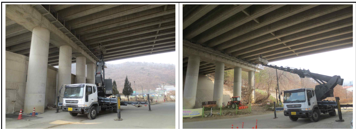
[그림 3.10] 금남IC Ramp-A교(상) 현장조사 현황
