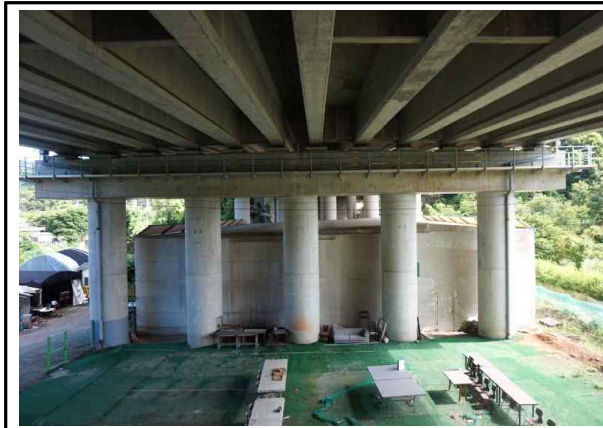
교각 P1 전경
