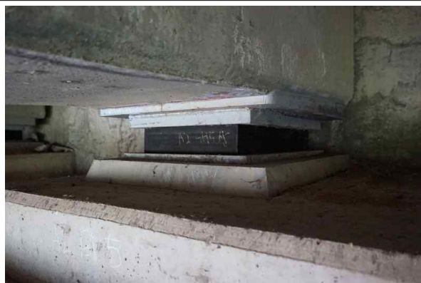
받침장치 보수 상태양호 A2 SH3
