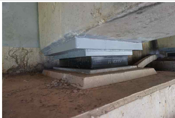
받침장치 보수 상태양호 A1 SH4
