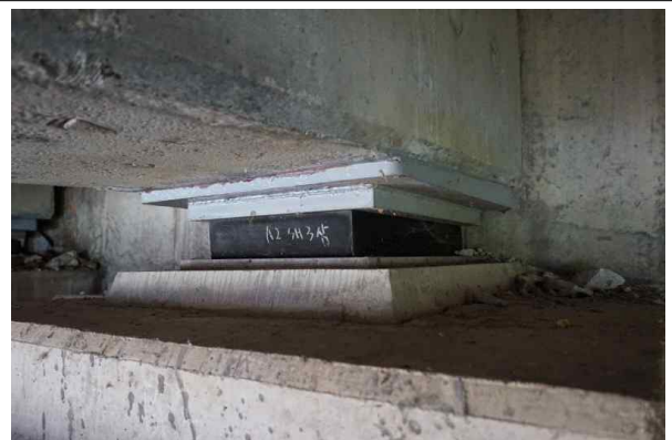
받침장치 보수 상태양호 A2 SH5
